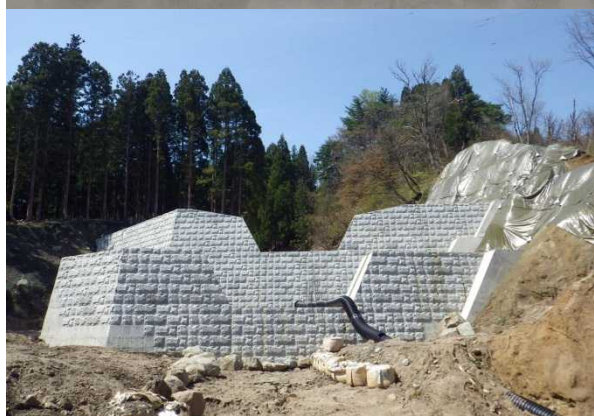
優良工事事務所長表彰受賞 高平沢第1号砂防堰堤災害関連緊急工事 施工:株式会社 種村建設
