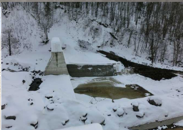
優良工事局長表彰受賞 上野原第3号砂防堰堤工事 施工:株式会社 竹花組
