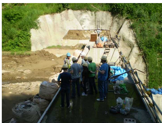
仮排水路設置に伴う堆積土砂の処理方法の説明
