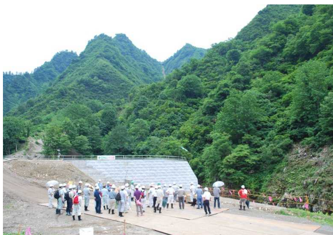
高石上流第2号砂防堰堤工事現場での説明
