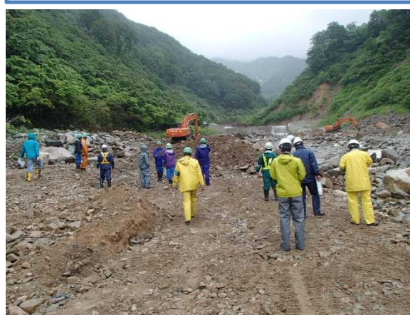
檜倉沢第5号砂防堰堤工事の点検状況
