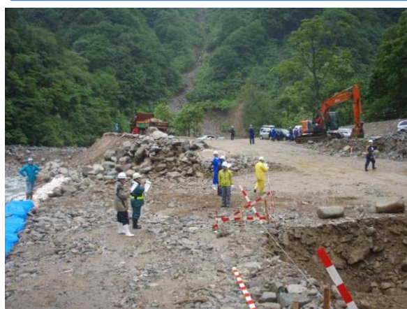
檜倉沢第1号砂防堰堤第2副堰堤その2工事の点検状況
