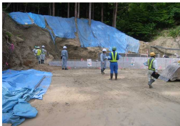
高平沢第2号砂防堰堤災害関連緊急工事 においての現場点検状況
