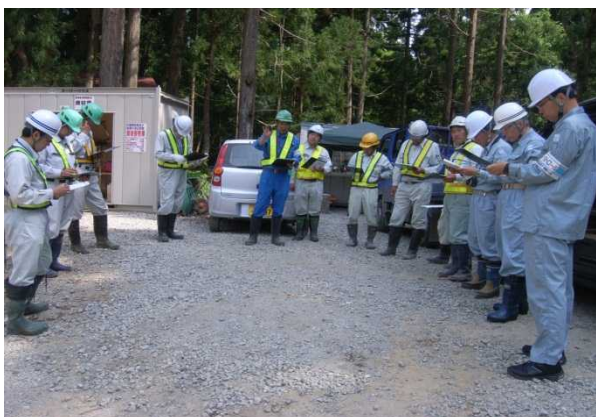
高平沢溪流保全工他工事 において点検前の工事概要説明
