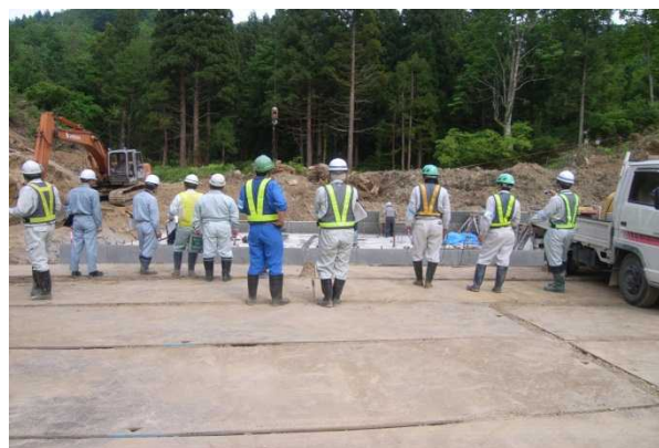
蛭窪第1号砂防堰堤災害関連緊急工事 においての現場点検状況
