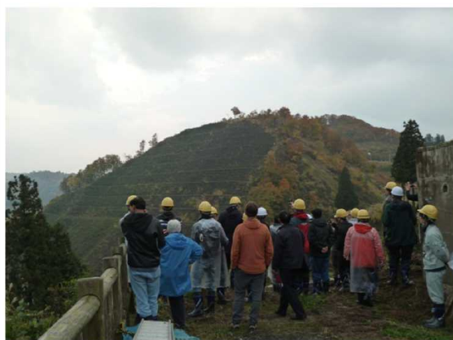
南平池谷の高台より砂防・地すべり対策工を見学
