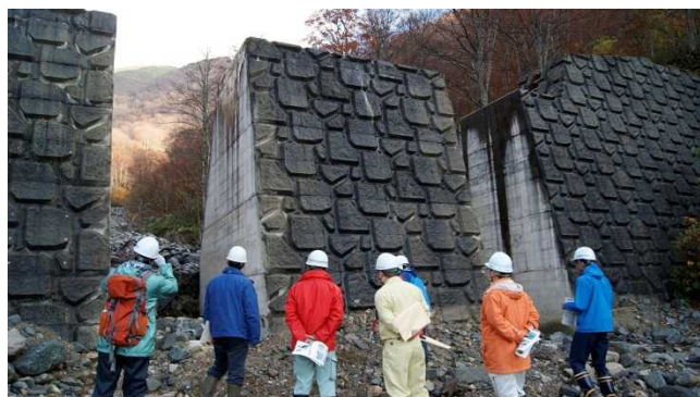
現地視察（洸沢第5号砂防堰堤）
