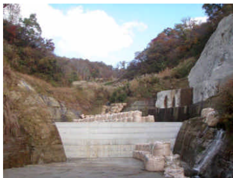
西願寺川上流砂防堰堤工事 施工：株式会社 廣瀬
