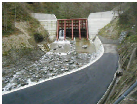
野中沢第2号砂防堰堤その2工事 施工：株式会社 羽吹組
