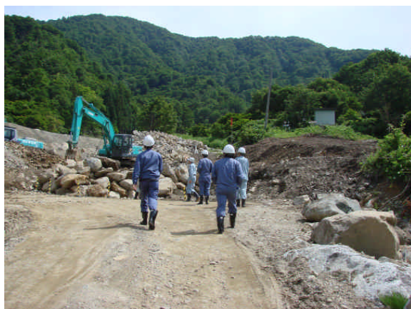
土石流災害の対策についての調査状況
