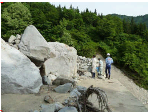
土石流を捕捉した深沢第3号砂防堰堤
