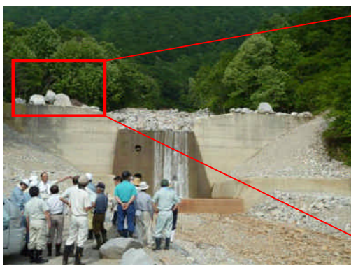
土石流を捕捉した深沢第3号砂防堰堤
