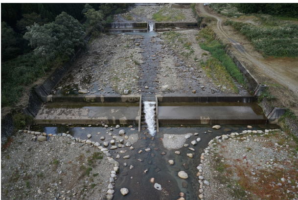
施工箇所全景（着手前）
