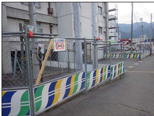
ガードフェンス設置状況
