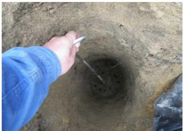
【写真3】 埋設物探索棒 使用例
