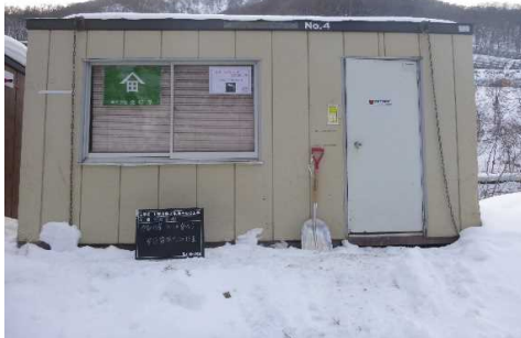
写-11 雪崩監視小屋
