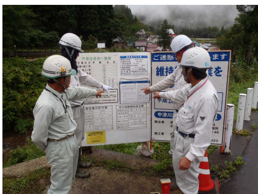
(安全利用点検指摘事項の補修)
