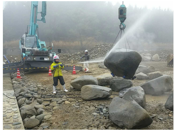
巨石吊上げ状況
