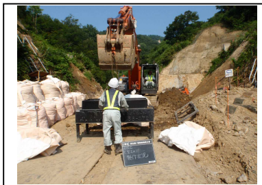
写真6 大型土のう製作器
