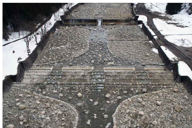
施工箇所全景（完成）
