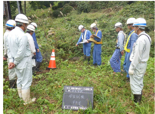
【写真1】 安全訓練 現地既設埋設物説明
