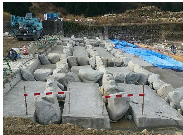
巨石胴込コンクリート打設完了
