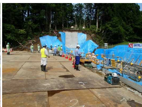
大形砂防堰堤工事 パトロール状況
