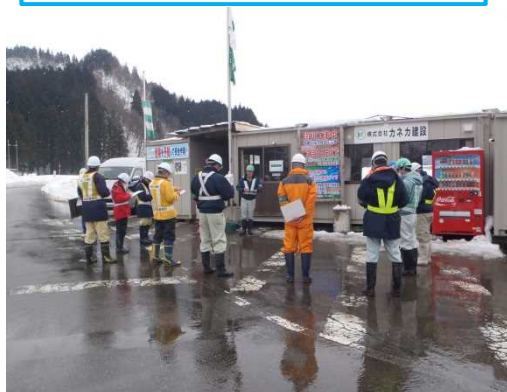
高棚川溪流保全工工事 意見交換
