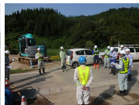
源太山川砂防堰堤工事 意見交換
