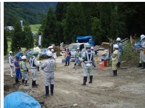
高平沢溪流保全工他工事 意見交換
