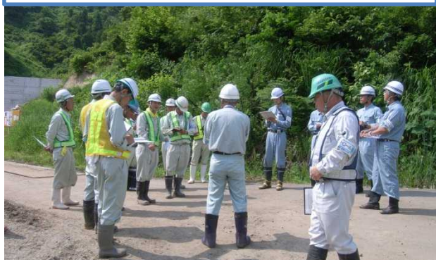
南平アシ沢外砂防堰堤工事 反省会(報告会)
