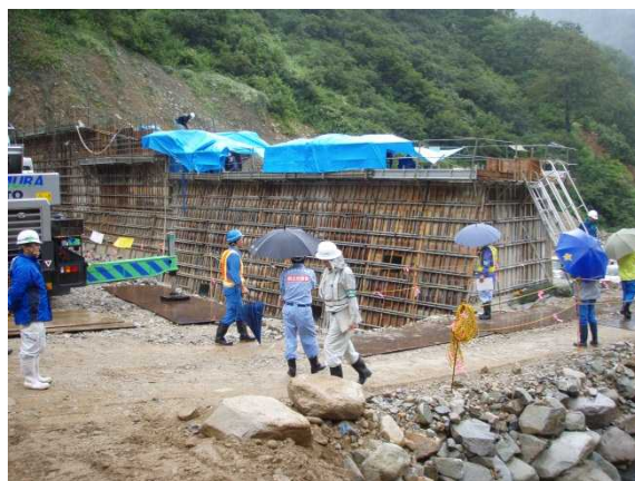
檜倉沢砂防堰堤群工事 点検状況
