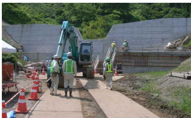
南平アシ沢外砂防堰堤工事 パトロール状況
