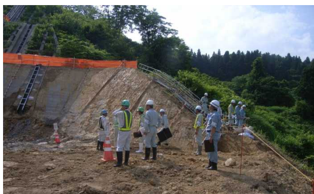
上塩谷地区地すべり対策その4工事 パトロール状況
