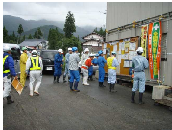
大源太川第1号砂防堰堤工事用道路他工事 現場事務所・掲示物点検状況
