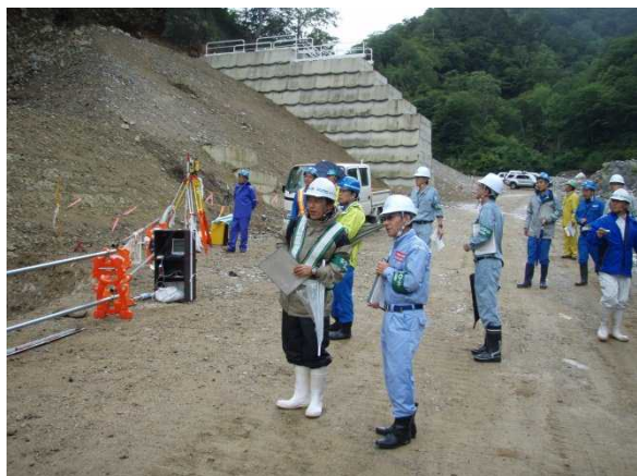
檜倉沢砂防堰堤群工事 点検状況
