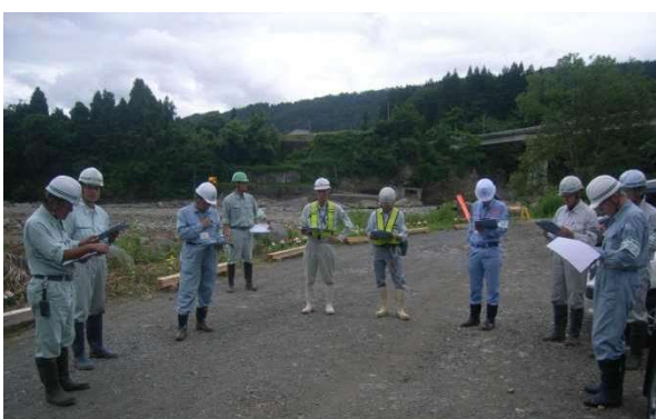
中津川床固工群補強工事 工事説明
