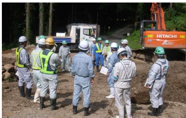
大倉砂防堰堤その2工事 工事説明
