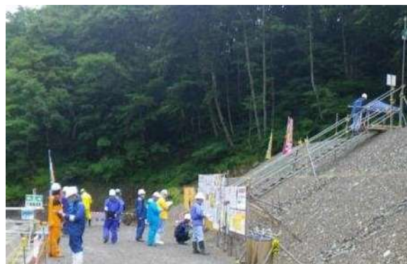
中津川上流溪流保全工その5工事 パトロール状況
