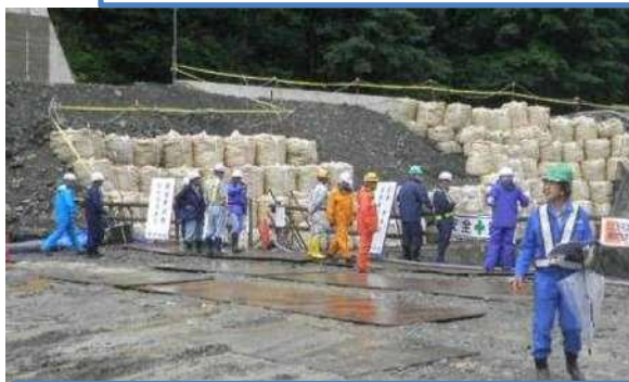
中津川上流第1号砂防堰堤その3工事 パトロール状況
