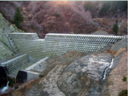
塩谷川砂防えん堤 各所に土砂ダムができた塩谷川からの土砂流出を防ぐブロック積みみの砂防えん堤
