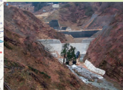
寺野第1号砂防えん堤 流域第二の土砂ダム対策として最下流を固める、コンクリートの砂防施設
