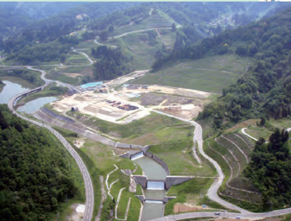
東竹沢第1号・第2号砂防えん堤 流域最大の土砂ダムを出現させた地すべりを抑えこむ流域最大級の砂防施設
