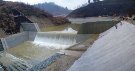
十二平砂防えん堤 芋川本川の最下流に位置するコンクリートの砂防えん堤
