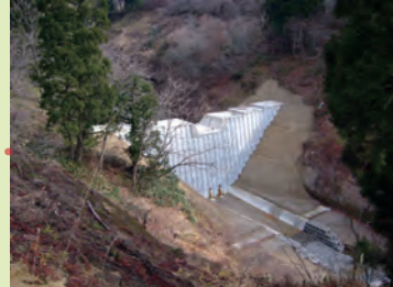
西願寺川砂防えん堤 西願寺川から横木集落付近への土砂流出を防ぐ、土砂をつめた砂防施設
