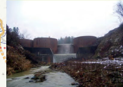
南平砂防えん堤 上流からの土砂流出を防ぐ、土砂をつめた円筒を並べた施設
