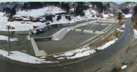
竜光遊砂地 芋川上流からの土砂流出に備え、流域最大集落である竜光地区を守る砂防施設
