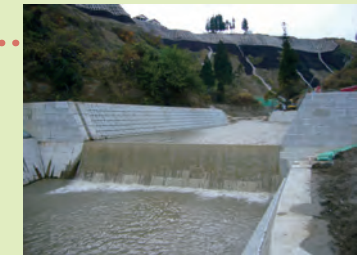
横木砂防えん堤・流路工 牛舎下で土砂に埋まった300m区間を整備した砂防施設
