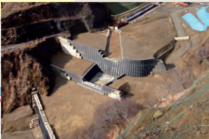
寺野第2号・第3号砂防えん堤 地すべりの原因となる地下水を通す、鋼製枠式の砂防施設
