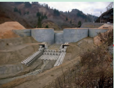
神沢川地区砂防えん堤 上流からの土砂流出を防ぐ、土砂をつめた円筒を並べた施設
