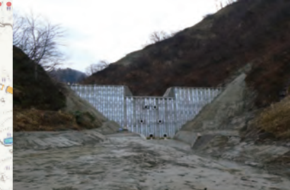
冷子沢川砂防えん堤 冷子沢川から木籠集落付近への土砂流出を防ぐ、土砂をつめた砂防施設
