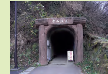
中山隧道 昭和8年から16年をかけて、住民の手によって掘られた全長877mのトンネル。隧道(手掘りのトンネル)としては日本最長。
