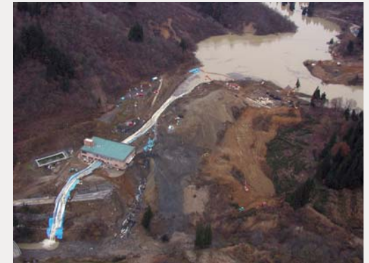
上流、東竹沢地区で起きた河道閉塞 (ポンプ排水の様子)
