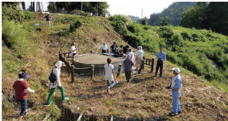
砂防講習会 梶金地区にて集水井を見学 2012.09.05
