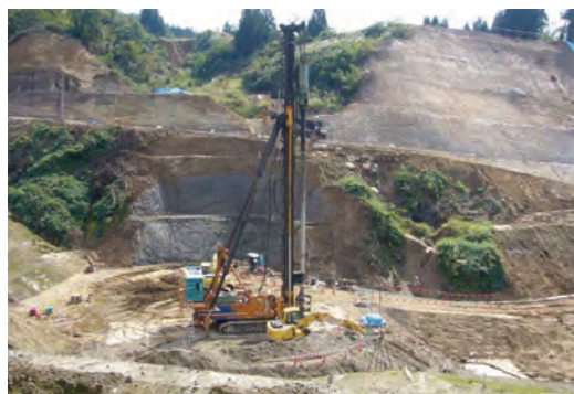
東竹沢地区の地盤改良のようす 2005.10.07
