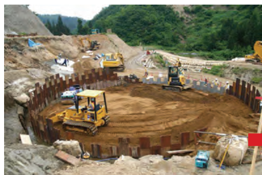
神沢川砂防えん堤 2006.06.15
