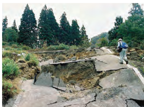
土砂災害対策支援チームによる現地調査 2004.11.01
