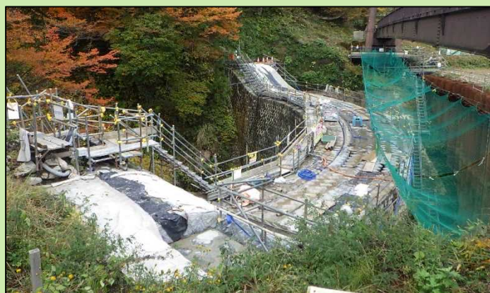
新堰堤天端(左岸側より)
