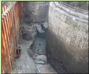
掘削完了 (右岸より)
