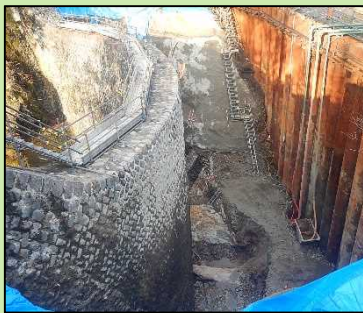
掘削完了 (左岸より)
