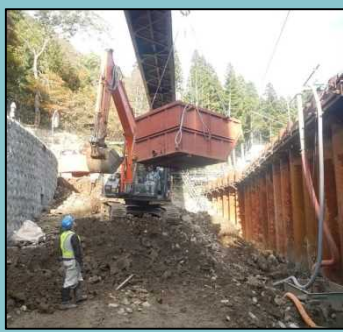
新堰堤部掘削工 施工状況
