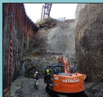
12月末掘削完了状況
