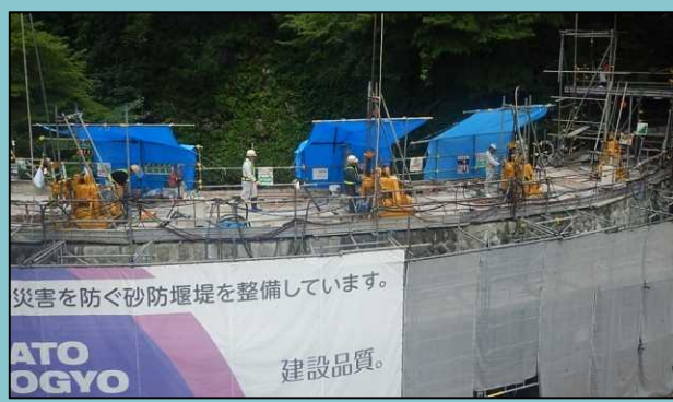
堰堤補強工（グラウチング）
