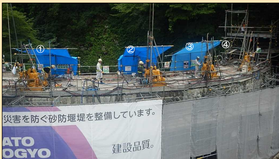
ボーリングマシン4台による施工状況
