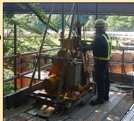
既設堰堤の削孔状況
