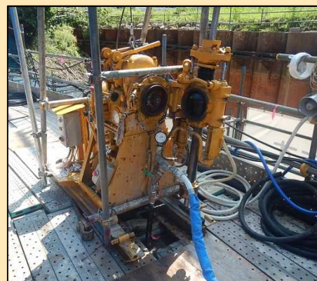
充填材の注入状況
