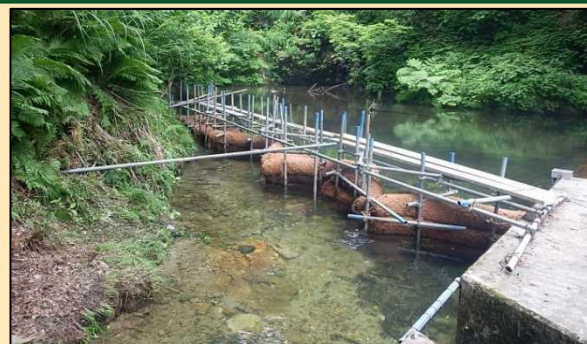
濁水防止フィルター設置完了
