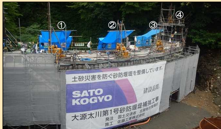
ボーリングマシン4台による施工状況（全景）
