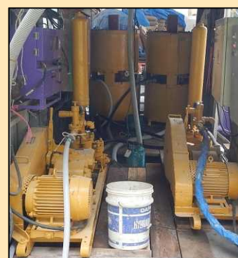
充填材を攪拌するミキサーと グラウトポンプ
