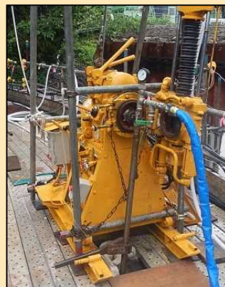
充填材の注入状況
