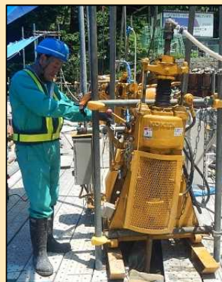
既設堰堤の削孔状況
