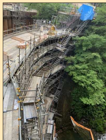
写真-右：堰堤下流側に設置した足場
