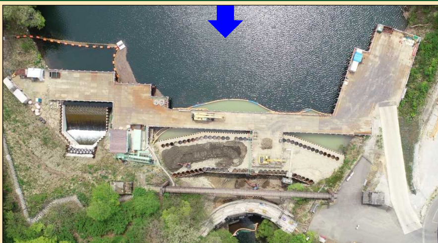
上空から見た工事現場
