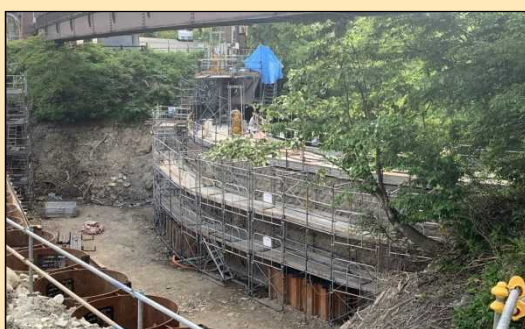
写真-上：堰堤上流に設置した足場
