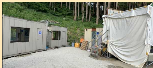
栈橋右岸端部に設置した注入プラント
