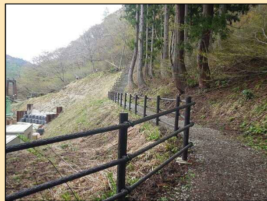
復旧が完了した遊歩道
