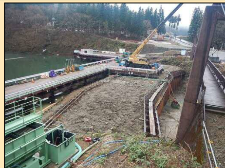
仮締切工 完成（全景）
