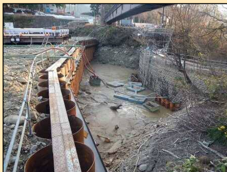
水替工の状況
