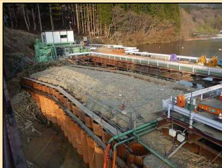
仮締切工 完成
