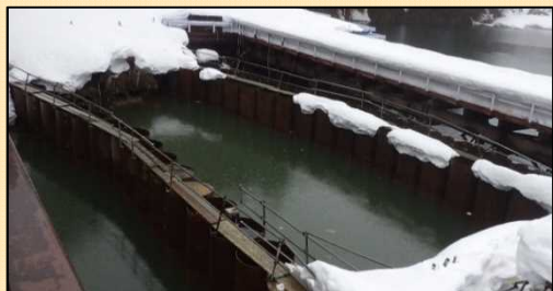
右岸側仮締切（31年3月撮影）
