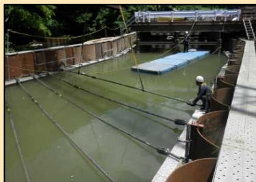
タイロッドの設置（左岸側施工時の状況）
