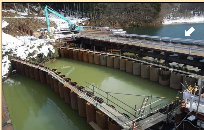
仮締切工(右岸側)
