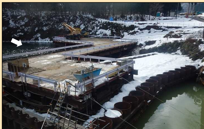
仮締切工(左岸側)
