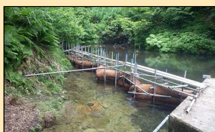
濁水防止フィルター撤去前
