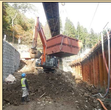
写真-ベッセルによる十砂揚重
