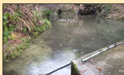
濁水防止フィルター撤去完了
