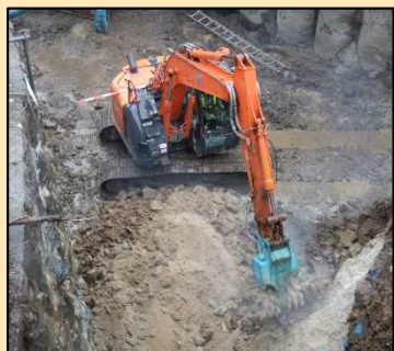
写真-ツインハッタ ® による岩盤掘削
