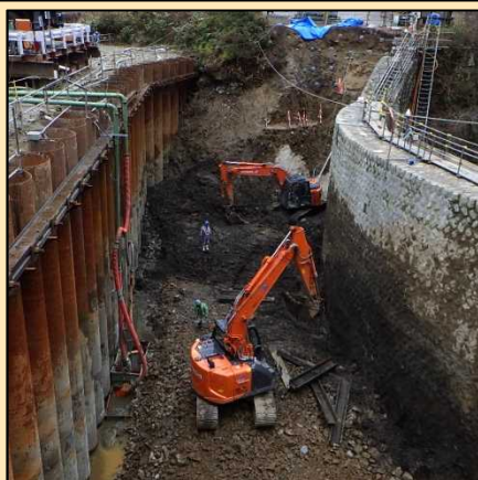
写真-ハック木による河床部掘削
