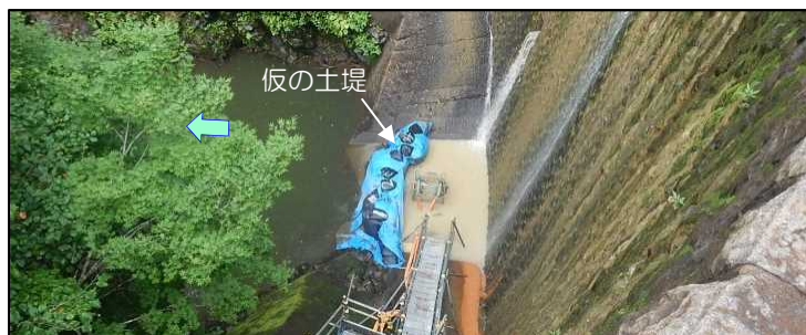
堰堤下流濁水対策
