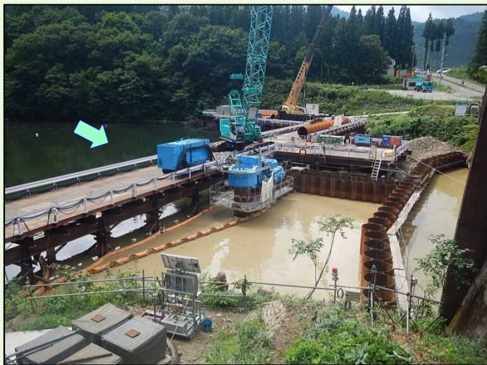
仮締切鋼管杭施工(右岸上流側)
