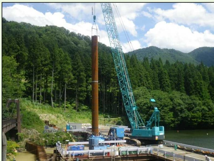
鋼管杭建込状況
