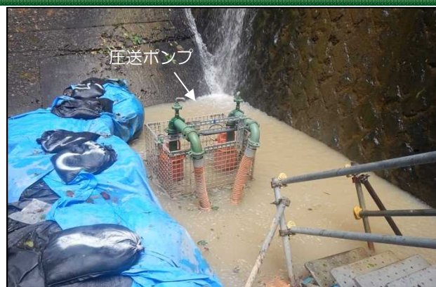
圧送ポンプの設置状況
