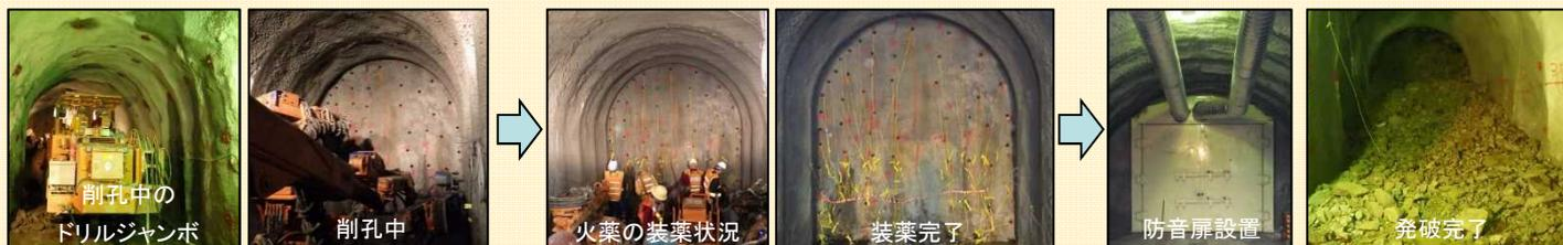
①ドリルジャンボでトンネル進行方向に火薬孔を開けます。孔は岩盤の硬さにより異なりますが、50cm間隔で1.7m程の深さです。
