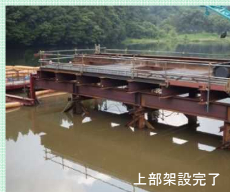
上部架設状況
