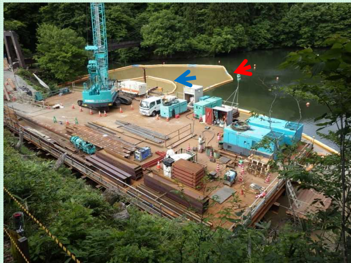
仮棧橋工施工状況
