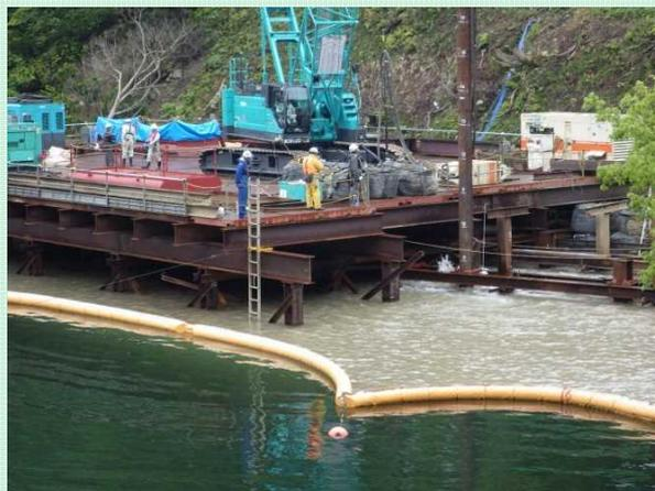
施工中の濁水防止対策工(汚濁防止フェンス)
