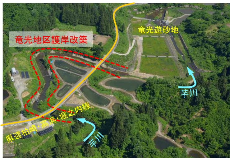
竜光地区護岸工
