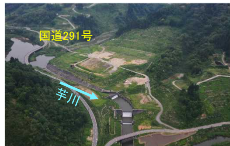
東竹沢砂防堰堤群
