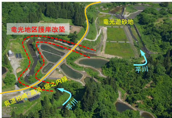
竜光地区護岸工
