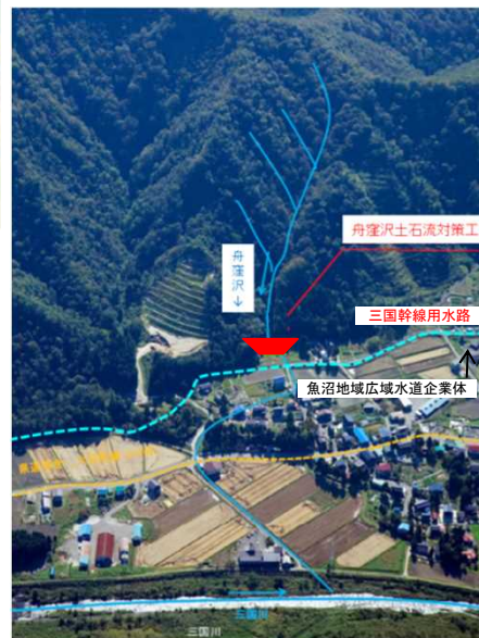
舟窪沢土石流堆積工
