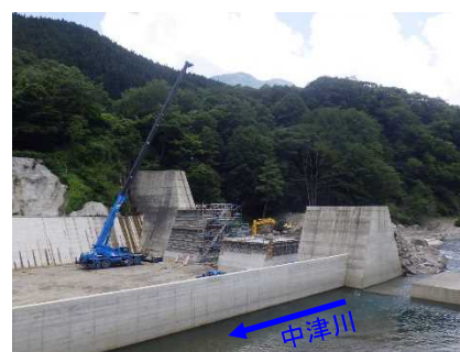
中津川上流1号砂防堰堤の施工状況
