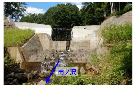
市ノ沢第2号砂防堰堤(令和元年完成)
