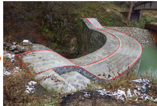
上流側にコンクリートを腹付けして補強
