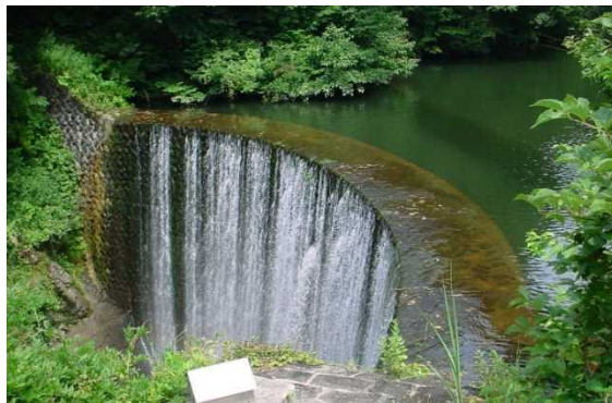
改築前の大源太川第1号砂防堰堤
