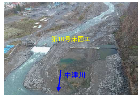
第10号床固工の施工状況
