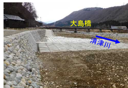
三俣溪流保全工の施工状況
