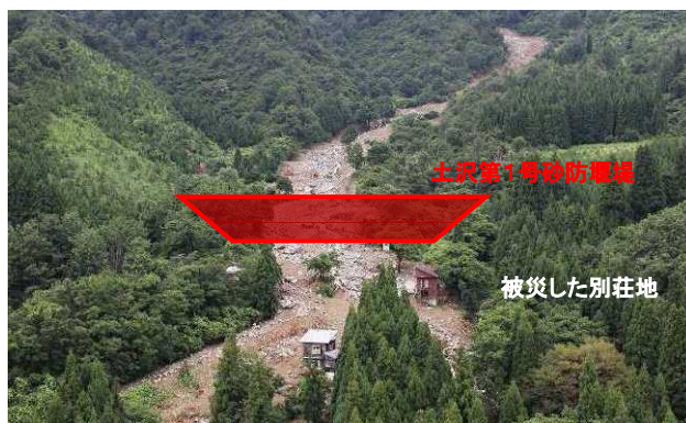
不安定土砂が堆積する堰堤計画位置（土沢）
