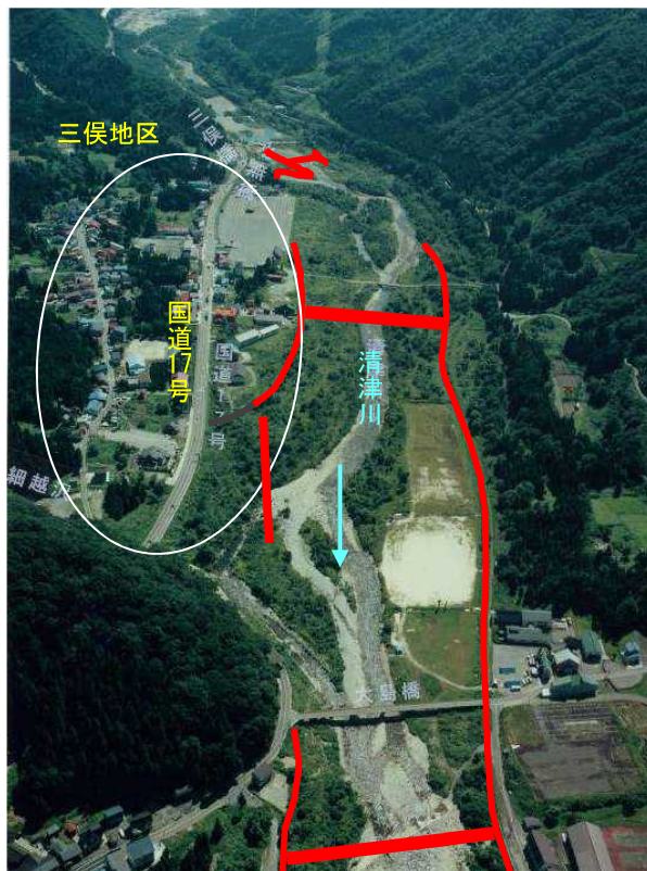
清津川沿いに立地する三俣地区や国道17号等を保全するため、溪流保全工を整備します
