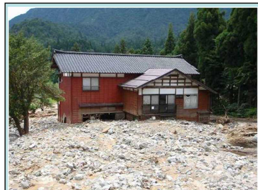
被災した溪流直下流の家屋
