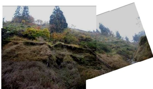
堰堤計画地点上流の崩壊地
