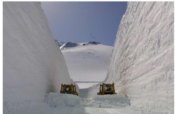
写真8 ブルドーザ2台による雪の壁の切り下げ
