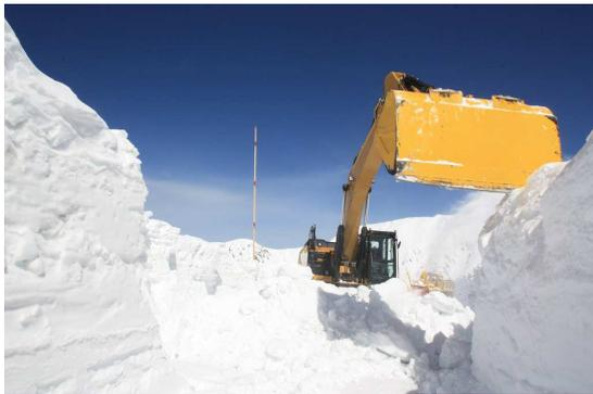
写真6 ③拡幅除雪（バックホウ）
