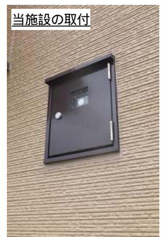
写真8 照明用自動点滅装置
