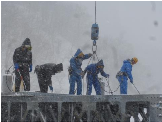
写真－１ 融雪除去状況
