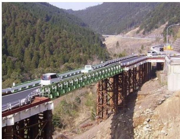
写真－５ 日南災害復旧仮橋
