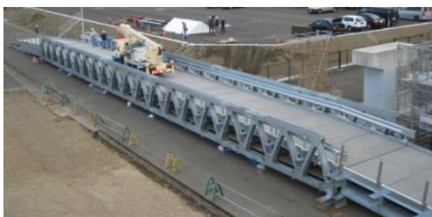
写真－６ 東北地方整備局保有応急組立橋
