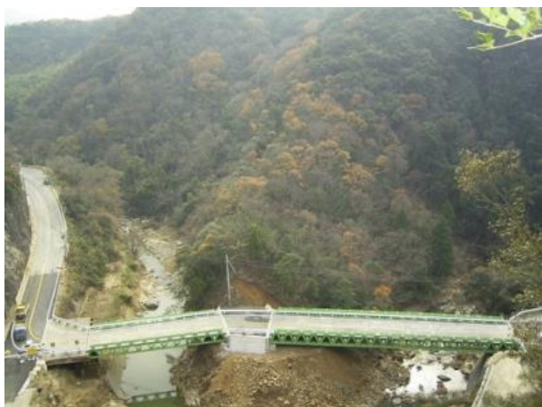
写真－４ 洲本災害復旧仮橋
