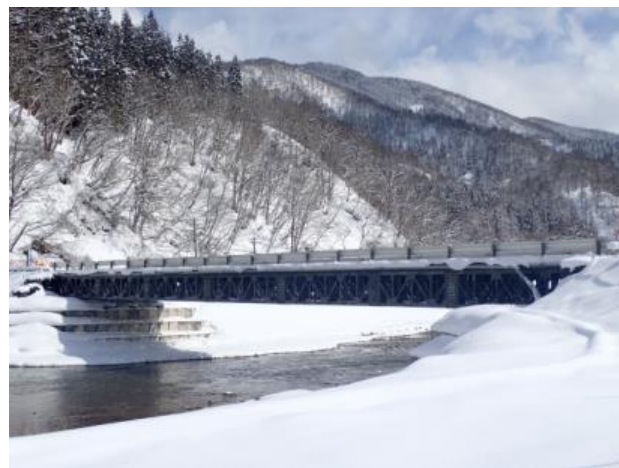
写真－７ 応急組立橋架設完了状況
