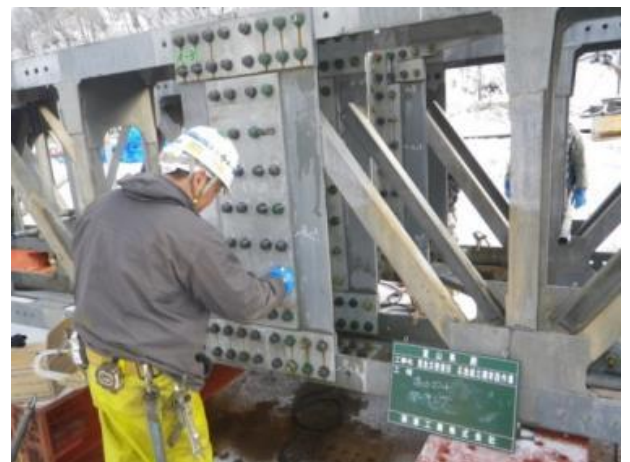
写真－３ 応急組立橋の主桁接合部組立状況（側面）
