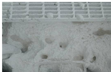
写真9. 粉末状プロナト投入後の溶解槽の状況
