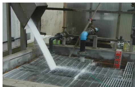
写真10. 粒状プロナト投入後の薬剤庫外の状況
