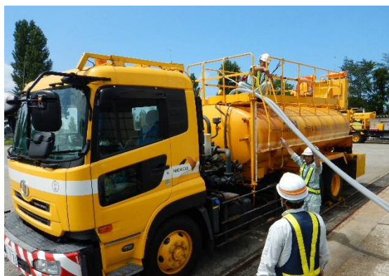
写真 1 1. 粉末状プロナト投入後の溶解槽の状況
