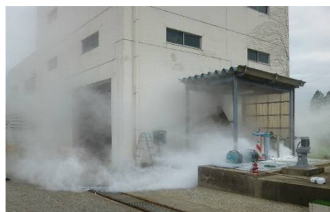
写真8. 粉末状プロナト投入後の溶解槽の状況
