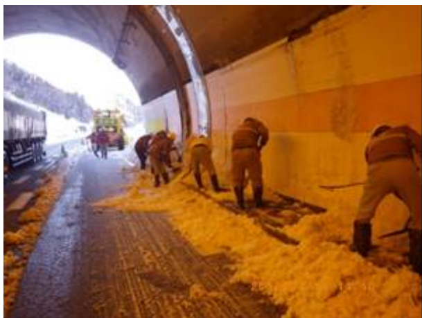
写真7 トンネル坑口部持込み雪の除雪作業
