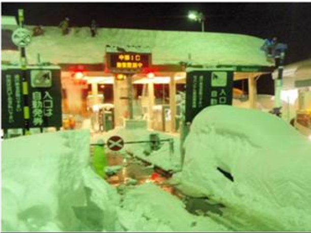
写真1 IC 閉鎖を伴うトールゲート上屋の除雪作業
