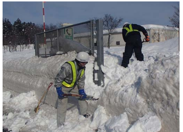
写真3 非常電話の除雪作業
