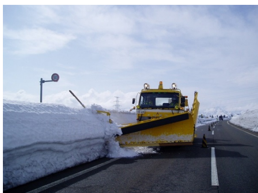
（写真-11）中分雪堤処理
