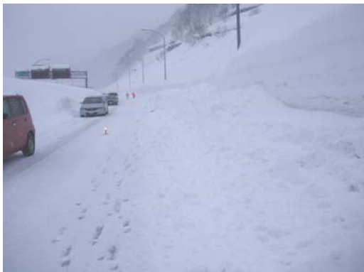
(写真-1) 堆雪による誘導標の埋没
