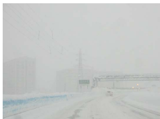
（写真-12）路肩のみの散布状況
