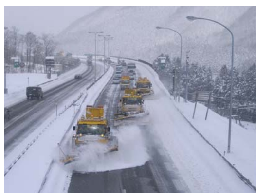
（写真-9）除雪編成による除雪作業状況
