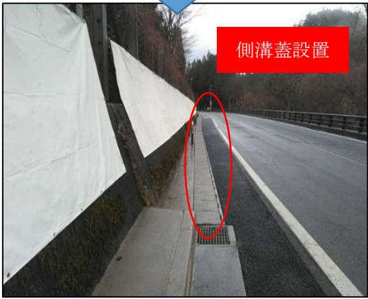
写真3 側溝の構造変更
