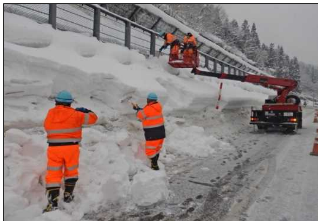
写真1 雪底処理状況
