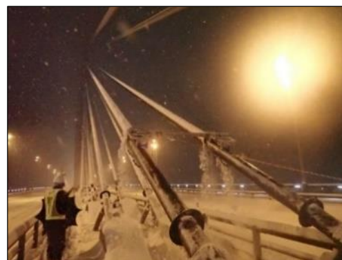
写真7 ケーブル除雪作業状況
