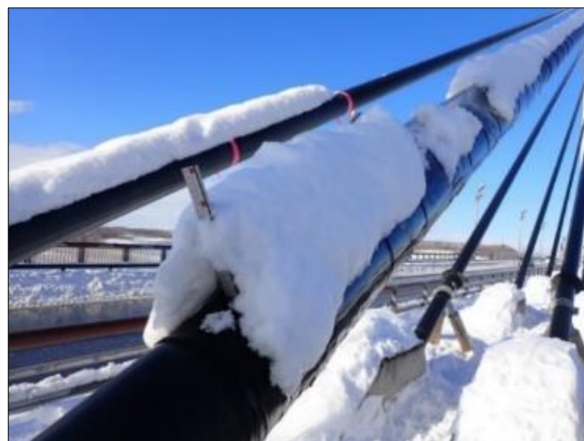
写真18 雪切板の落雪状況（右側）
