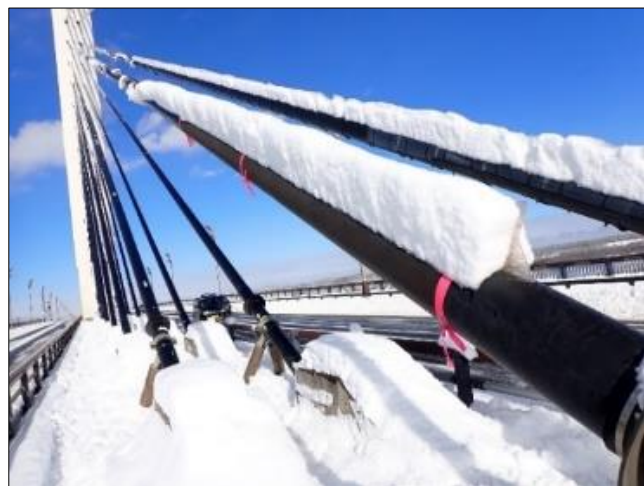
写真19 着雪防止塗装の落雪状況（左側）
