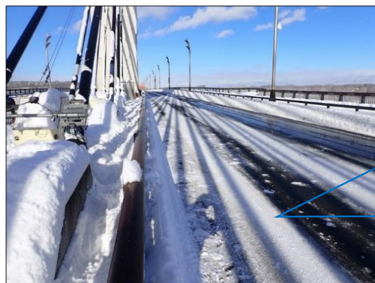
写真13 路面への落雪状況
