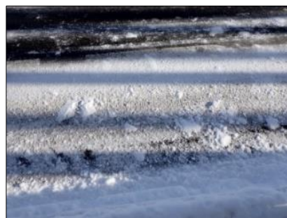
写真14 路面上の落雪痕
