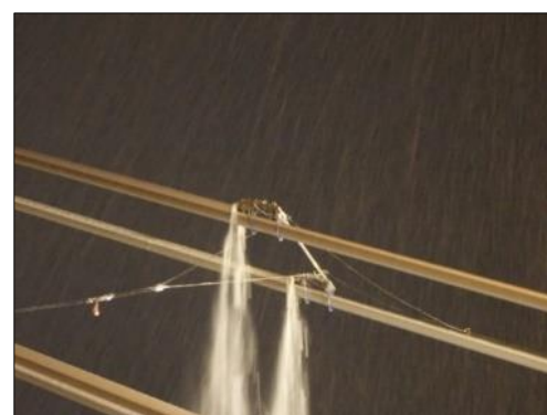
写真8 スクレーパー除雪状況
