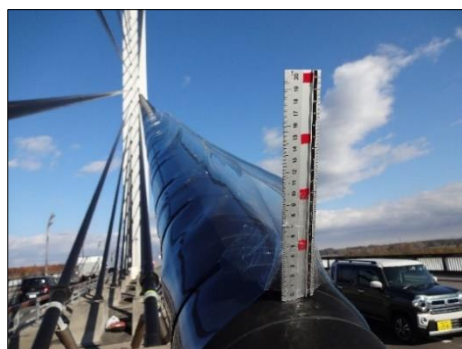
写真15 雪切板の設置状況
