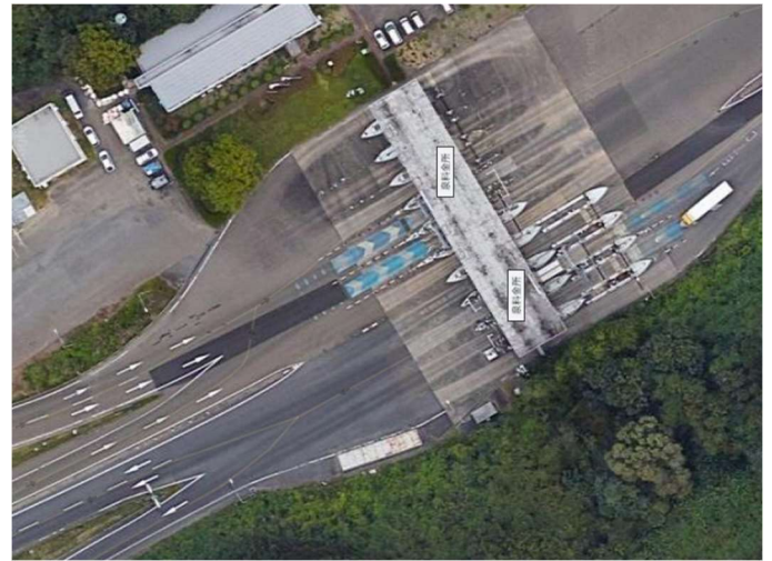
写真5 泉インターチェンジ
