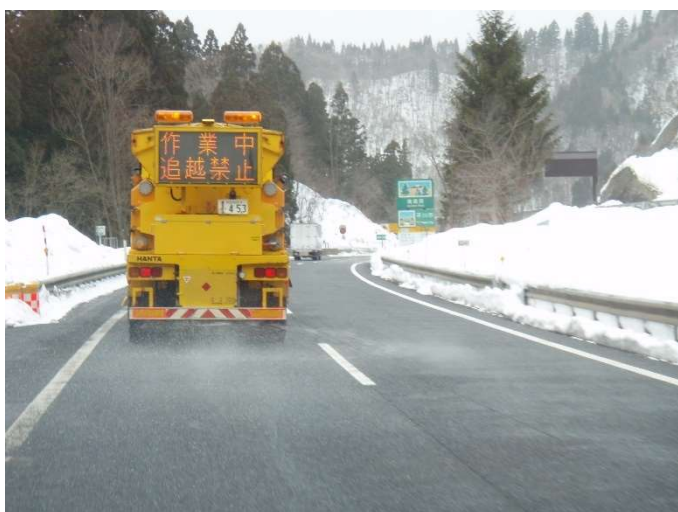
写真1 雪氷対策作業の状況
