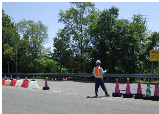
写真2 車両反転用開口部の状況
