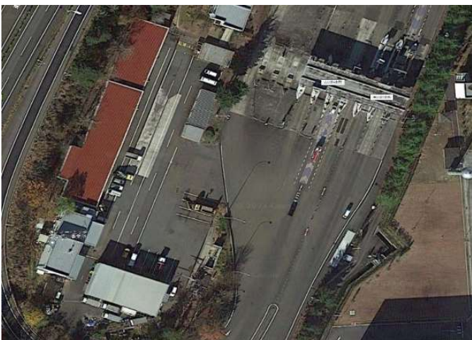
写真4 古川インターチェンジ
