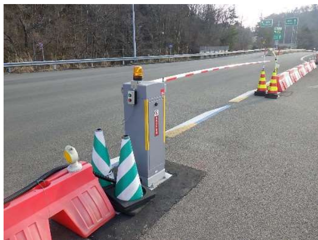
写真7 遠隔遮断器設置状況
