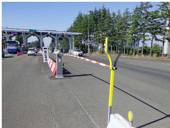
写真10 遠隔遮断器設置状況
