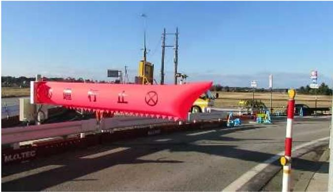
写真3 遠隔遮断機の設置状況
