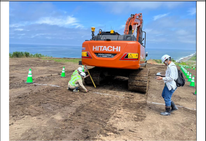
図 13 バックホウ走行試験
