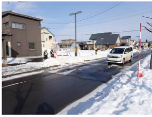
左側：除雪後の湿潤路面
