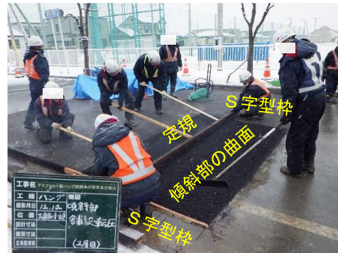
写真4 定規を使った傾斜部の曲面施工
