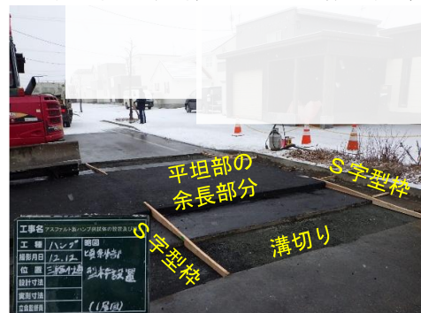
写真3 余長部分を加えた平坦部の施工延長
