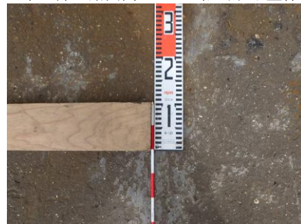
写真2 傾斜部の施工に使用したS字型枠の製作
