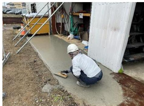
写真11 高熱伝導コンクリート打設状況
